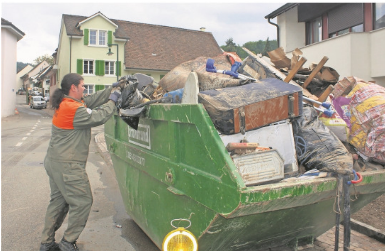
Ab auf die Mulde: Gestern waren über 40 Zivilschützer im Einsatz, auch heute werden sie wieder geflutete Wohnungen und Keller räumen.
