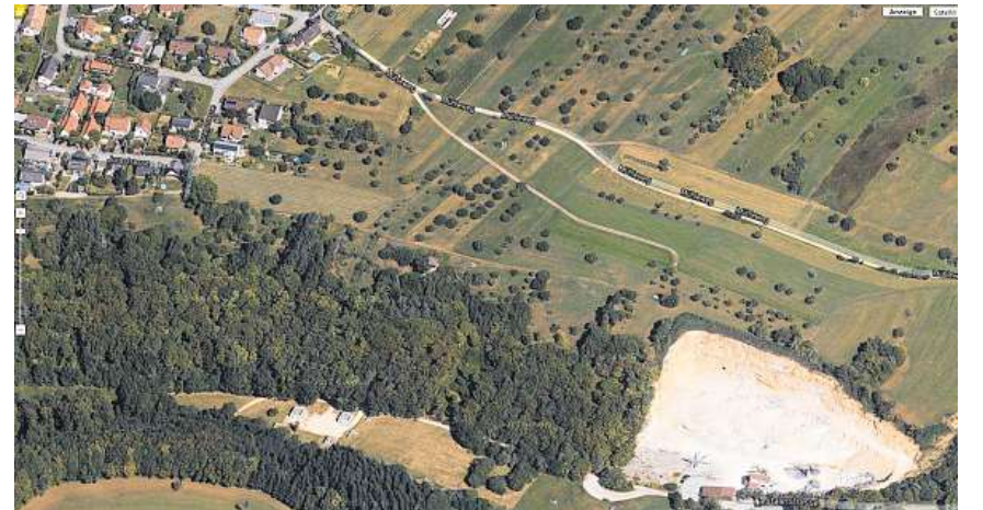
Zitternde Wände. Sprengungen der Surer AG im nahen Steinbruch verursachten Risse in den Häusern. Foto Google Earth
