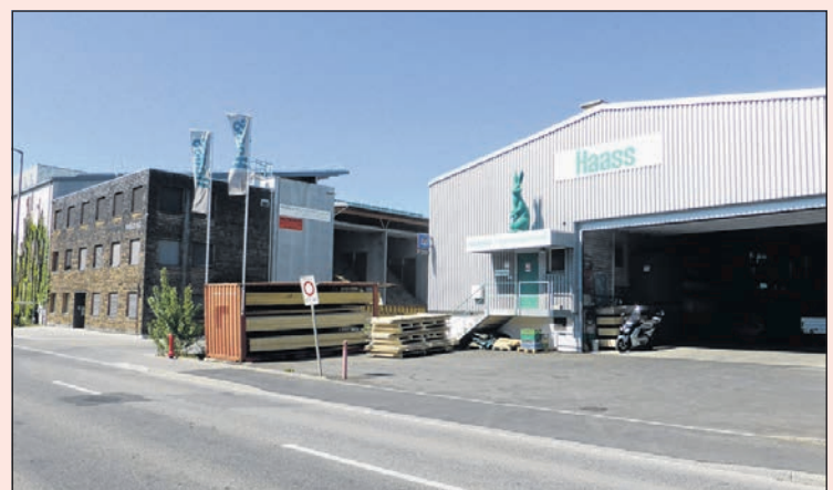
Heute: Die neue Halle steht rechts vom ehemaligen Fabrikgelände, welches neu überbaut wurde, 2020.
