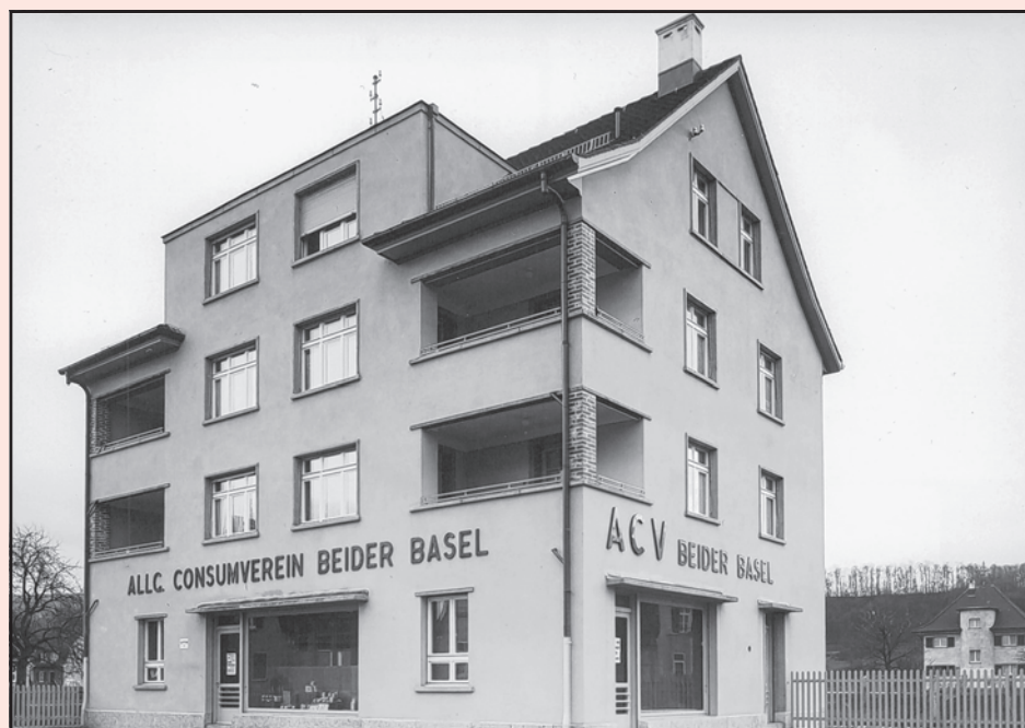
Hinterzweienstrasse 79, ohne Jahr, Betrieb 1932–1963.
