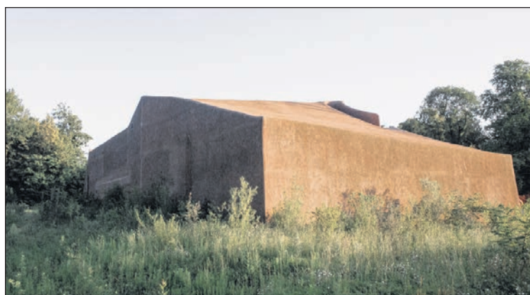
Die Anlage im MuttENZer Hardwald.
