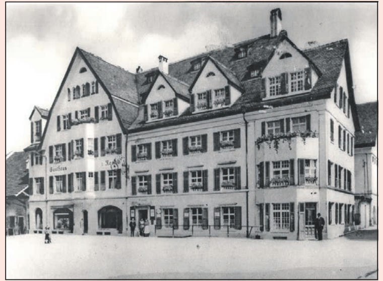
Nach dem Umbau 1909: Im giebelseitigen Hausteil, links Kaiser's Kaffeegeschäft, rechts davon die Metzgerei Rahm.
