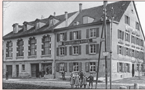
Der Bären um 1907, der Dorfbach ist noch offen, er wurde ab 1908 eingedeckt.
