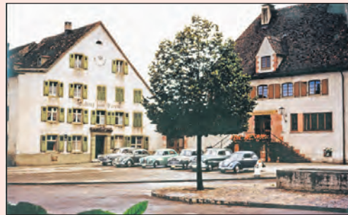
1942, Gasthof zum Bären und neues Gemeindehaus von 1942, heute steht hier das Mittenza.
