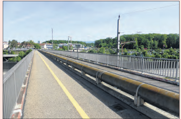
Heute: Passerelle mit Rohr der Trinkwasserversorgung für das Freulerquartier (2015). Foto Hanspeter Meier
