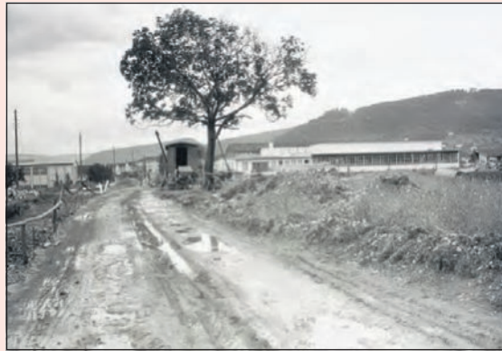
Hofackerstrasse vor der Korrektion, um 1955.
