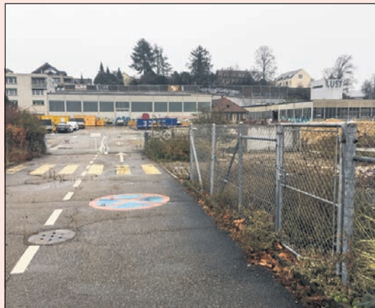
Heute: abrisssbereit für eine Überbauung.
