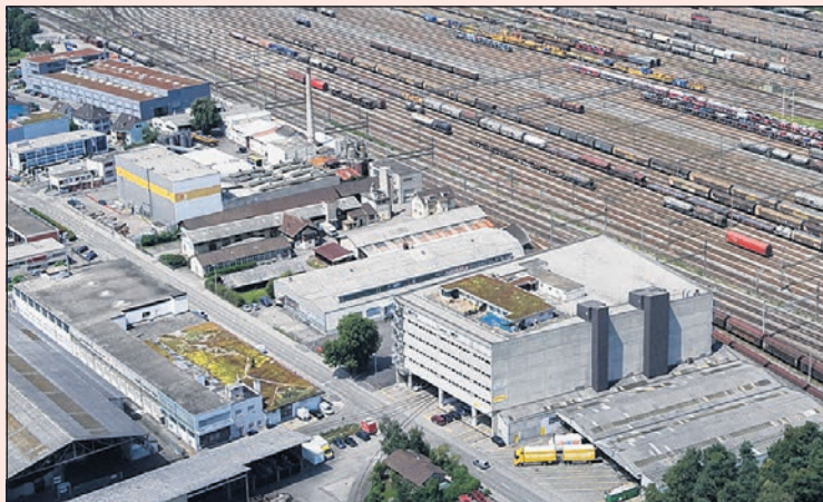
Gestern: CTW mit Produktionsgebäude (gelbe Markierung) und Hochkamin, Flugbild 2008.
