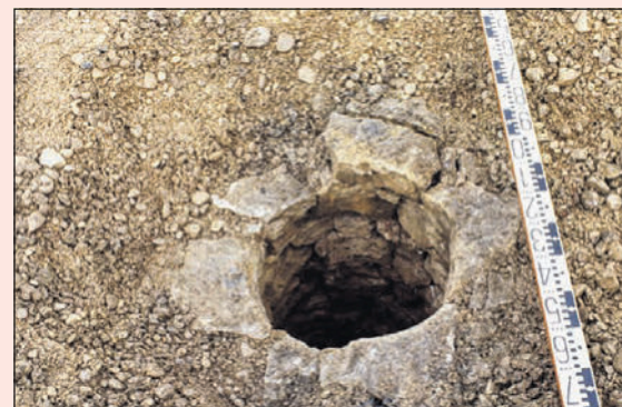
Gemauerter Lüftungsschacht, 1977.
