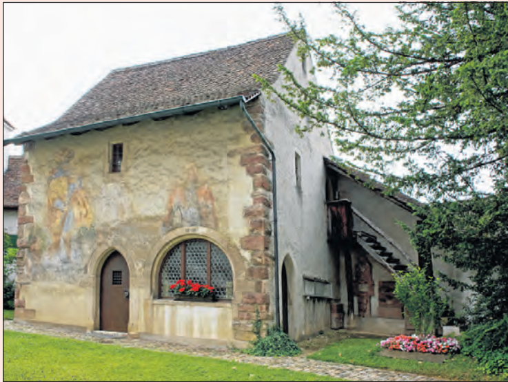
Das Massengrab der im Dienste Basels Gefallenen befindet sich im Kirchhof rechts neben dem Beinhaus.
